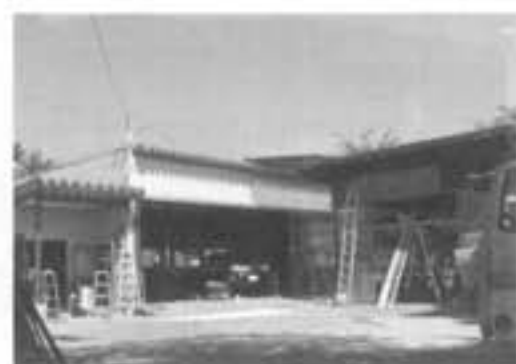
村井様 自動庫修理工事
