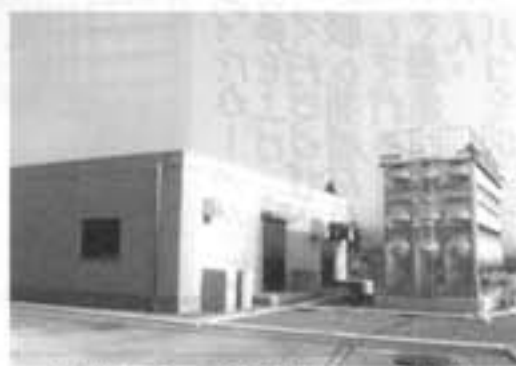
立石川増田町の場更新・改良工事
