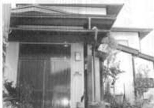
江俣 在司様 住宅改修工事
