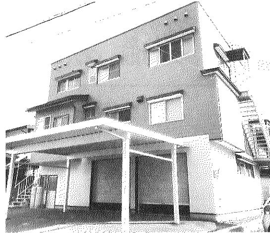
山形市あさひ町内K様邸 外壁塗装工事
