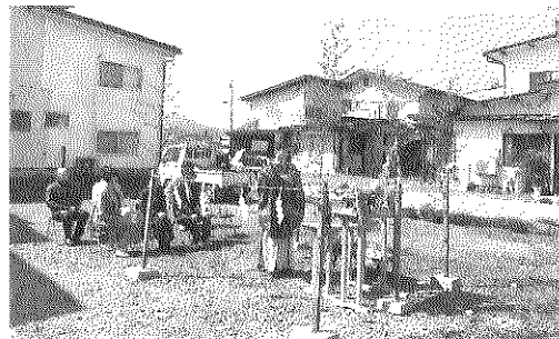
山形市内 H様邸 住新築工事
