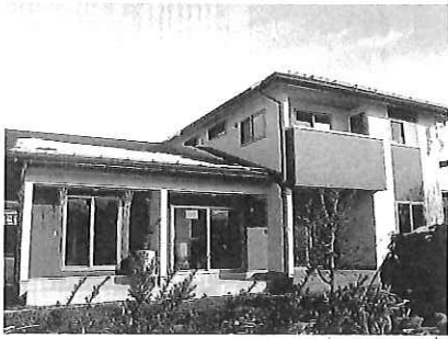
山形市藤田 O様邸 住宅新築工事
