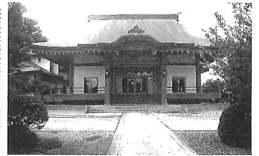
山形市町野地区 浄蓮寺様 耐震改修工事
