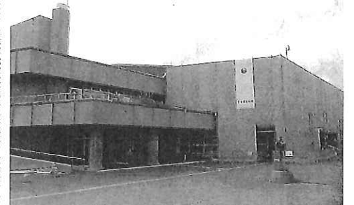
山形市香澄地区 山形市公会館 屋根葺き改修工事
