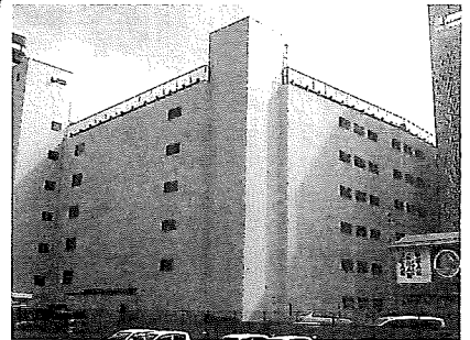
山形市中央駅前南面第1外壁修繕工事
