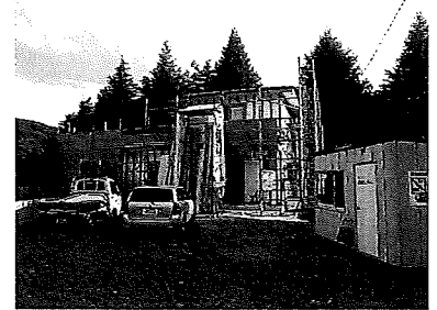
○山形市沼の辺地内 K様 住宅新築工事
