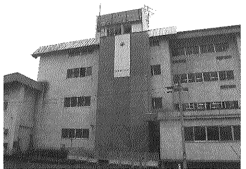
山形市立金井中学校トイレ改修 建築工事
