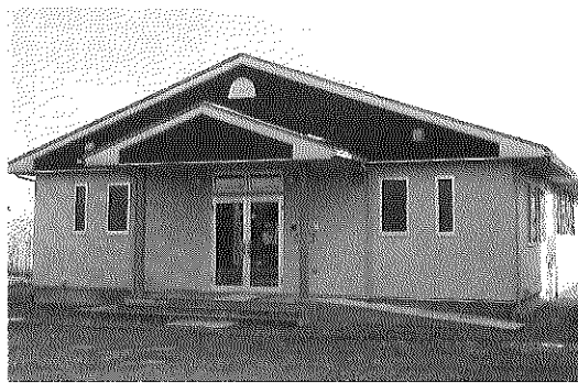
山形市障場新田地内 築3金井保育クラブ新築工事
