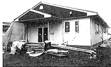
○山形市陣場新田 築35年築の改築工事
