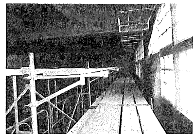
○金井山学校 武道場吊り天井等 落下防止工法工事
