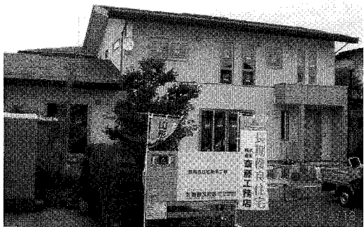
○ 天童市巾里地区 長岡様 住宅新築工事
