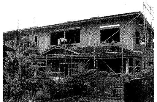
○ 宮町地区 泰蔵寺様 住宅増築工事
