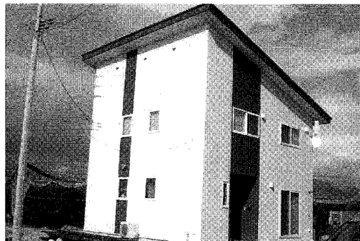
○ 東根市蟹沢地区 伊藤様 住宅新築工事
