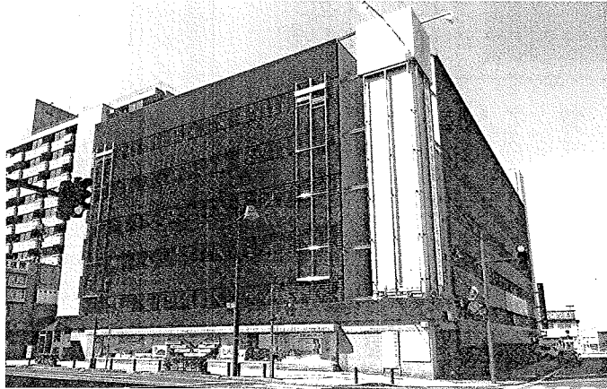
山形市 中央駅車ル-バ取付用鉄骨修繕工事
