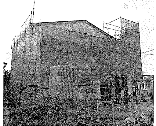
北町二丁目地内 西野様宅新築工事
