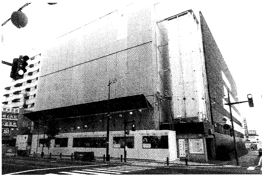
山形市 中央駅車ル-バ取付用 鉄骨修繕工事
