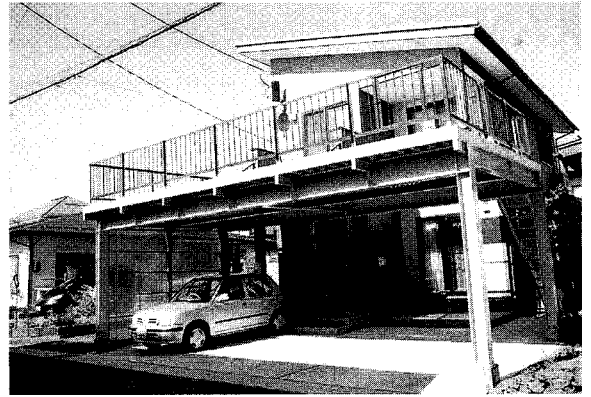
陸場新田地内 佐藤様 住宅新築工事
