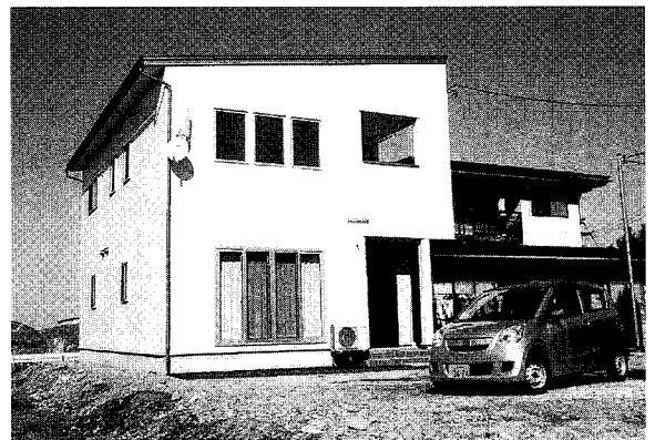
陸場新田地内 伊藤様 住宅新築工事
