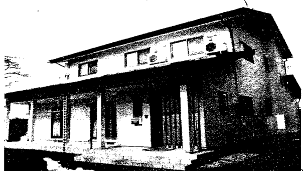
○陣場新田地内 斎藤様 住宅新築工事
