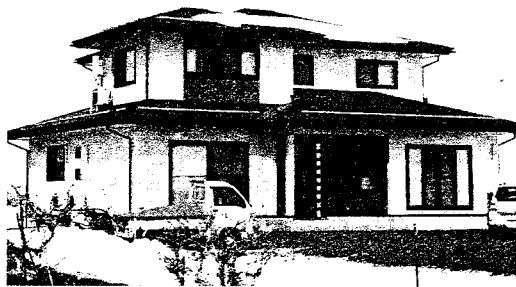
○陣場新田地内 斎藤様 住宅新築工事
