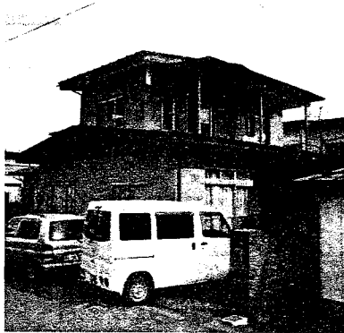
陣場新田地内 鈴木様 住宅改修工事
