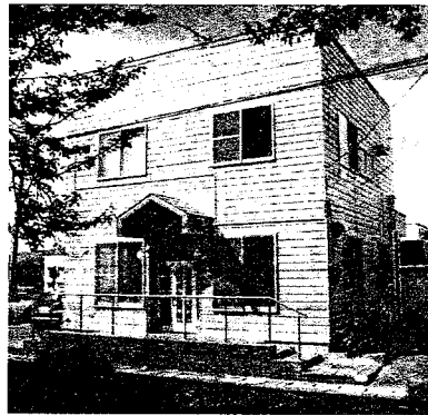
東青田地内 阿部様 貸店舗改修工事
