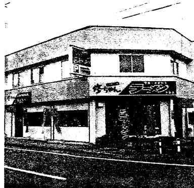
西田地内 (有)久喜開発様 貸店舗外壁改修工事
