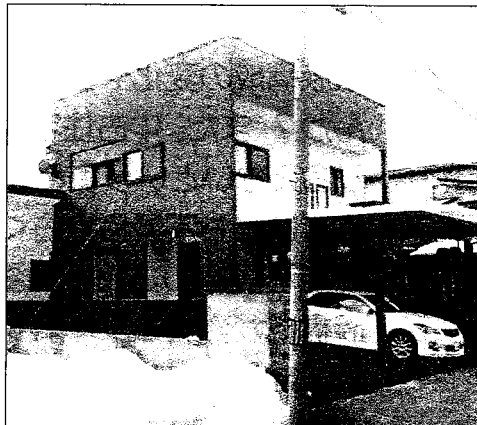
○ 山形市陣場新田地内 深瀬様 住宅新築工事
