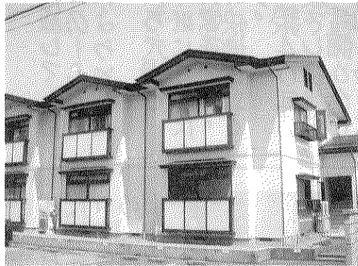
・丸喜開発様マンションA棟 外装 改修工事
