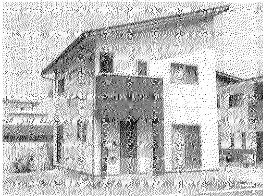
・南館 鈴木様住宅新築工事
