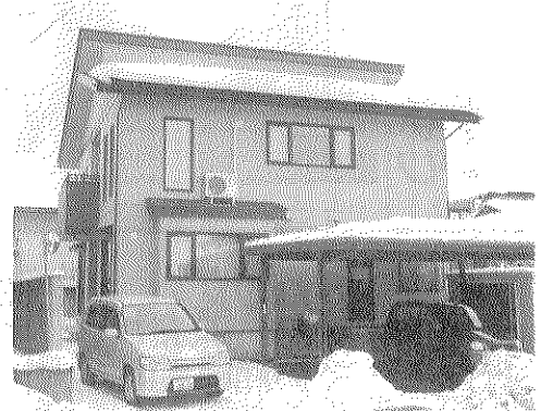
陣場新田 朝倉様 住宅新築工事
