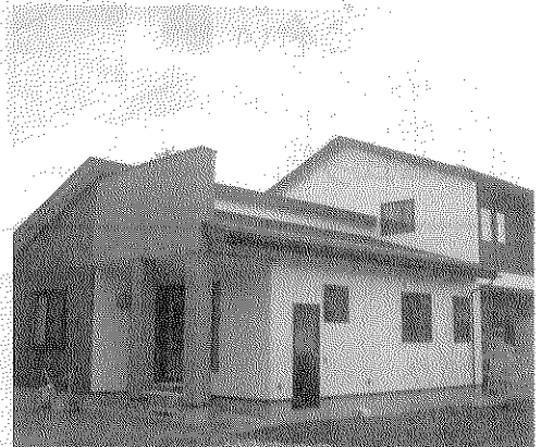
東根市 石塚様 住宅新築工事
