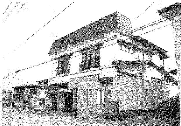
門伝 高橋様 玄関改修工事
