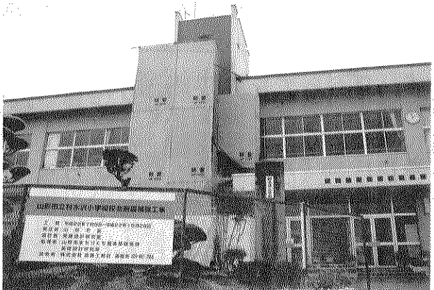
村沢小学校 校舎耐震補強工事
