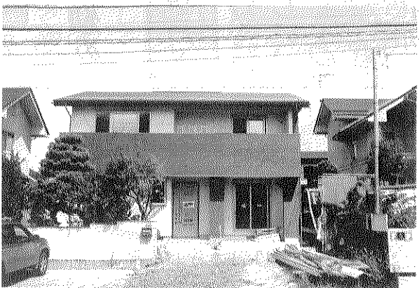
青田 新澤様 住宅新築工事
