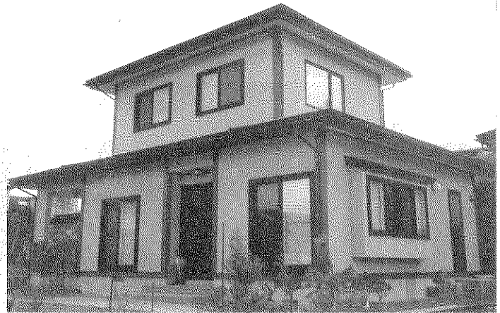
山辺町 佐藤様 住居新築工事
