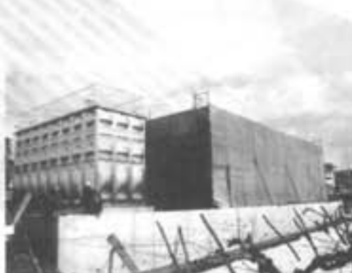
立石川宿舎 立石川宿舎 改修工事
