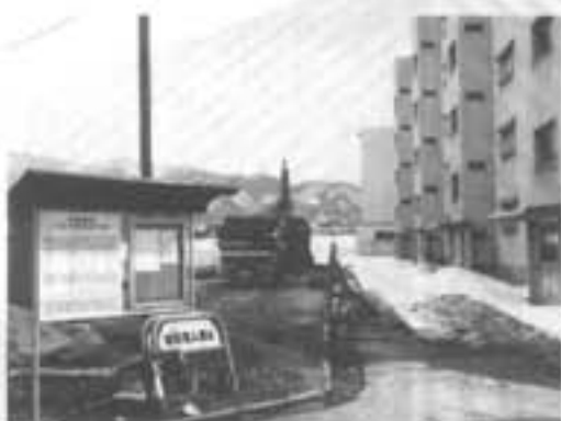
程用保進住宅 立石川宿舎 駐車場設置工事
