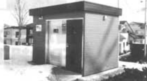
餅状地町内会給食室川町町数ヵ場工場の設備工事
