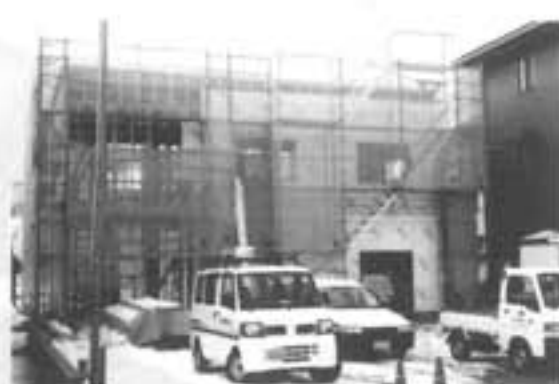
立石川宿舎 立石川宿舎 改修工事
