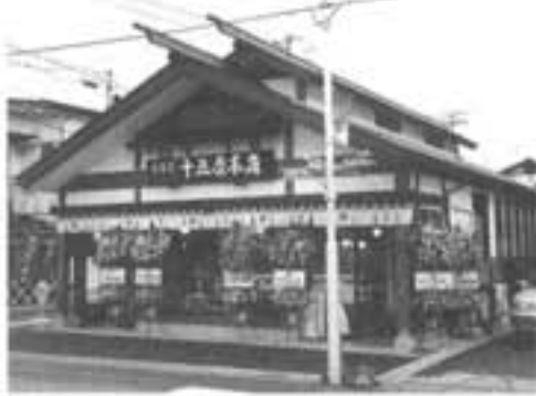
上山市(有)十五屋本店 店舗新築工事
