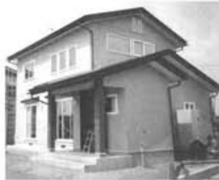
鳴及町内 成澤隆様住宅新築工事
