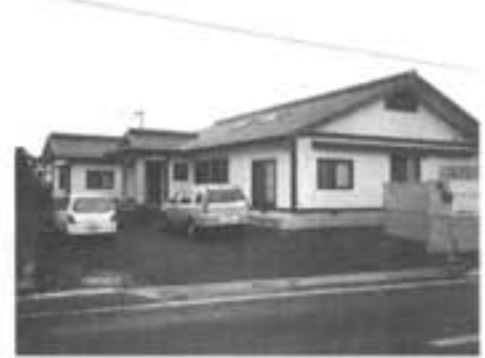
江保 佐藤川(四郎)様住宅新築工事
