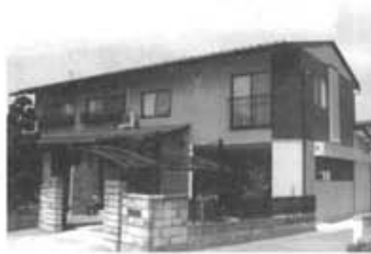
南原町 渡辺健二様住宅増築工事
