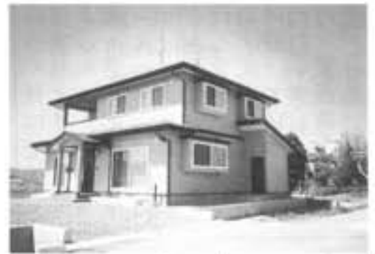
志田 須貝浩二様 住宅新築工事
