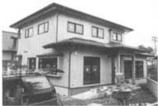
東根市武田秋男様 住宅新築工事
