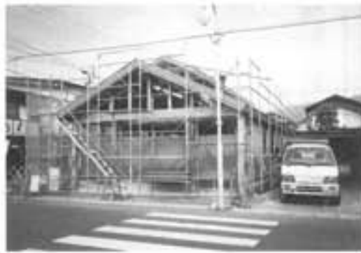
上麻市(有)十五屋本店 店舗新築工事
