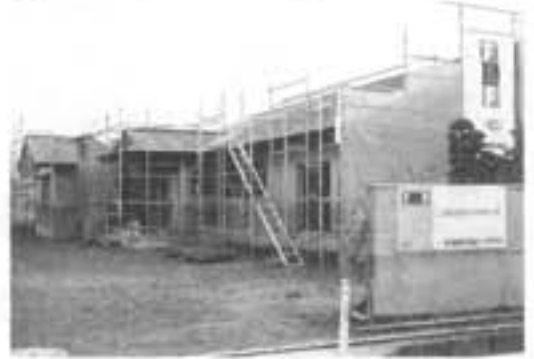
江俣 佐藤川四郎様 住宅新築工事
