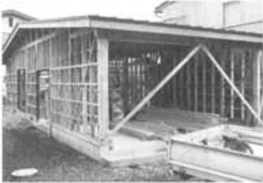
鉾田町 高橋伸行様 車庫新築工事
