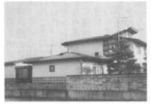
陣場 眞山義弘様 住宅改修工事
