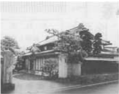
陣場新田 斎藤社雄様 住宅改修工事
