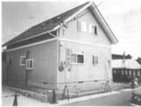
漆山 多田康志様 住宅新築工事
