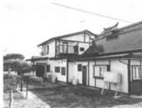
津金沢 島橋敏郎様 住宅増築工事
