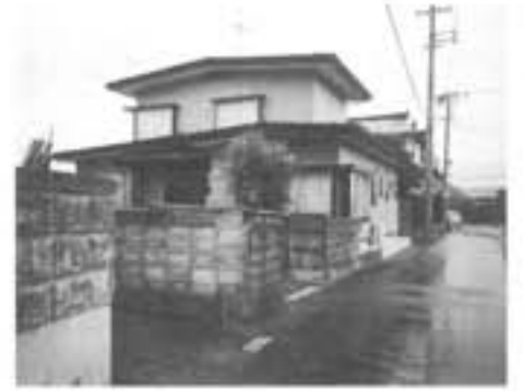
陣場新田 峯田房寿様 住宅改修工事
