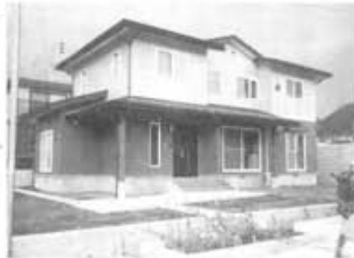
桜田 滝口孝彦様 住宅新築工事
