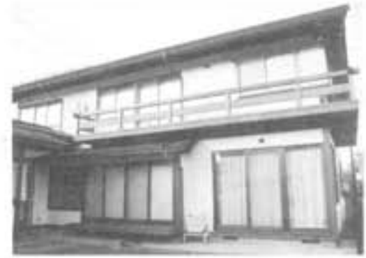
緑町 山下國子様 住宅新築工事
