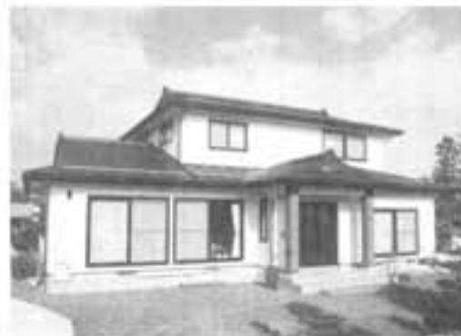
志戸田 遠藤弘一様 住宅新築工事
