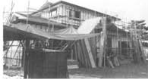
志田 遠藤弘一様 住新築工事
