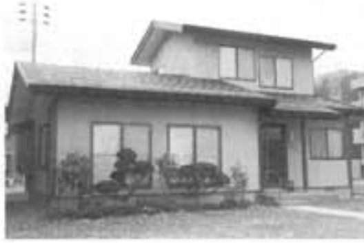
双葉町 志田幸様 住新築工事
