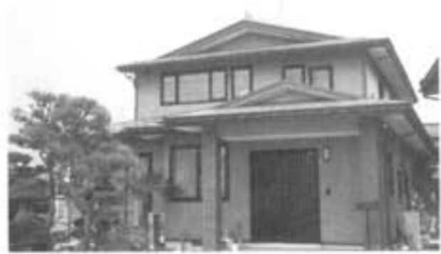
江俣 森谷 弘様 住宅新築工事
