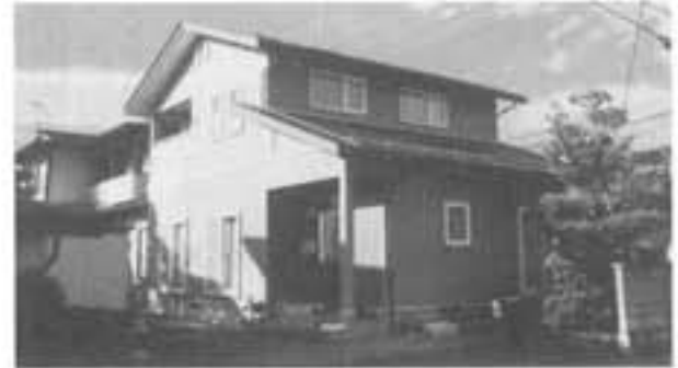
桜田西 高橋忠二様 住宅新築工事
