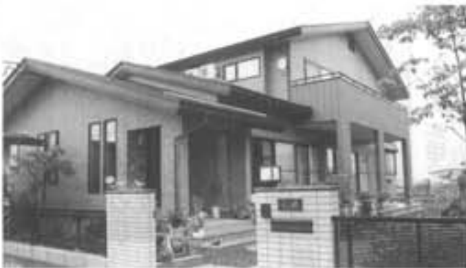
陣場新田 武田雅穂様 住宅新築工事
