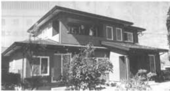
山辺町 後藤 啓様 住宅新築工事
