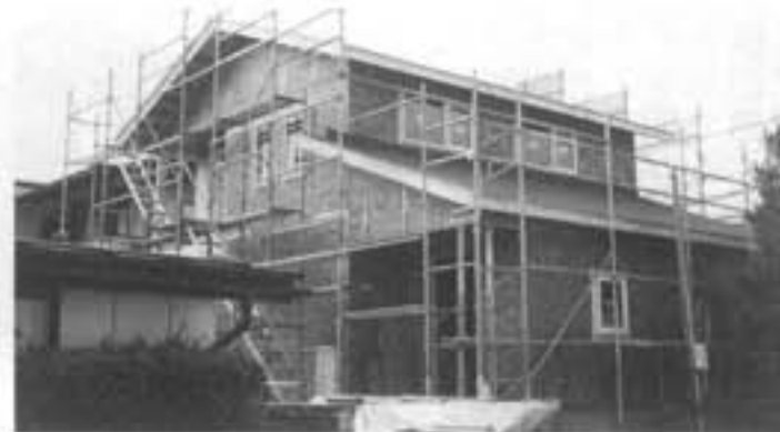
西田 高橋忠二様 住宅新築工事
