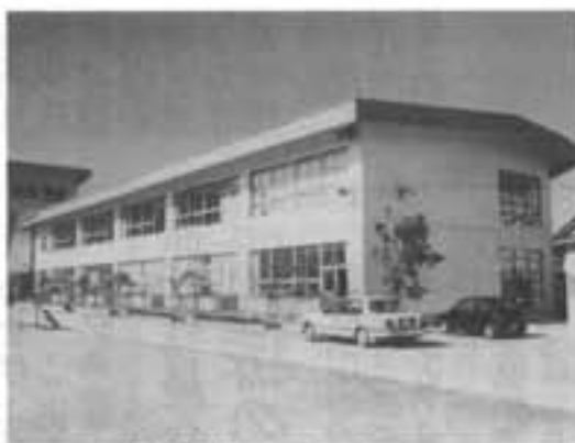
山形市立金井小学校
