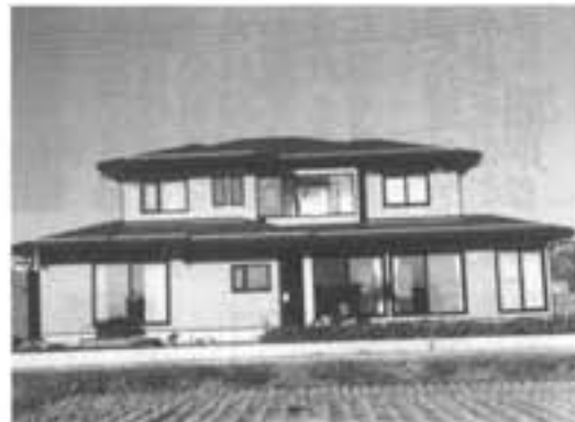
内表西 羽角伊和夫様 住宅新築工事
