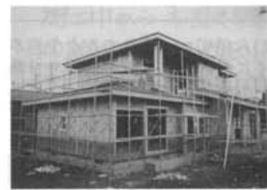
山辺町 後藤 啓様 住宅新築工事
