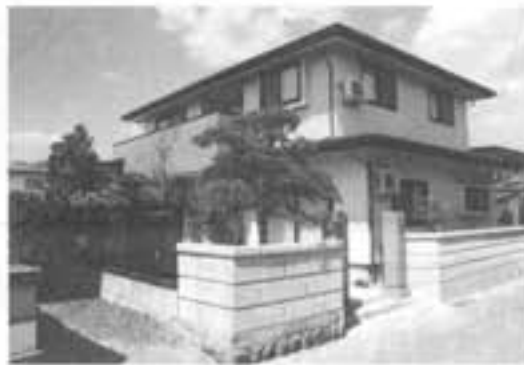
上山市 黒田淳一様 住宅新築工事
