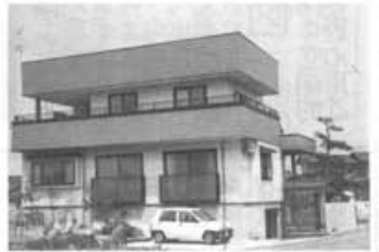
陣場新田 武田久雄様 住宅新築工事
