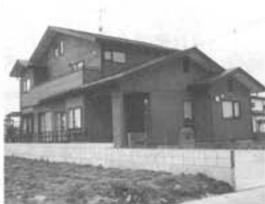
陣場新田 加藤 繁様 住宅及車庫 新築工事
