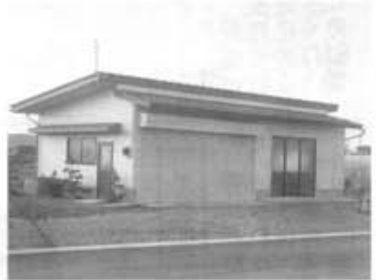
陣場新田 武田久雄様 車庫新築工事
