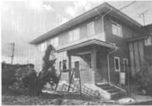
中山町 猪股喜永治様 住宅増築工事
