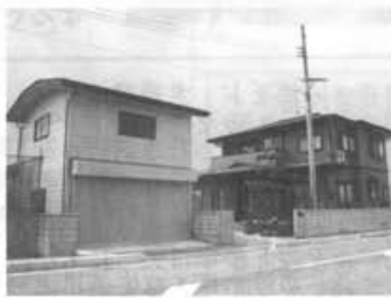
東志戸田 川口正治様 住宅及車庫 新築工事
