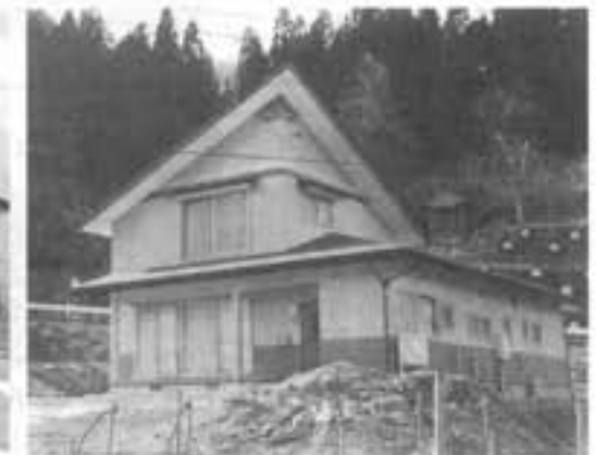
山辺町 樋口勝蔵様 住宅新築工事
