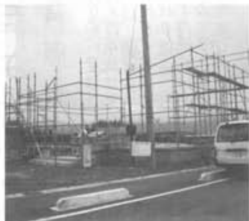
東志戸田 川口正治様 住宅新築工事
