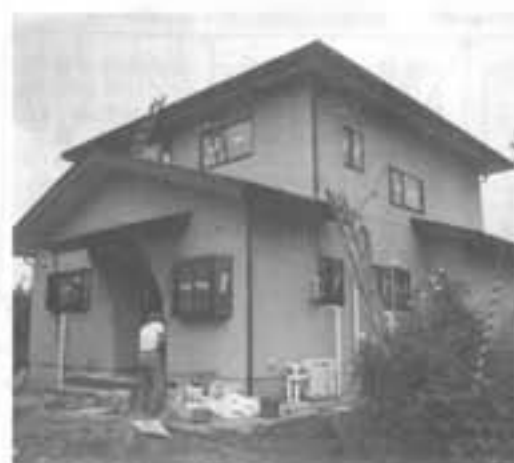
東志戸田 栗原隆夫様 住宅新築工事
