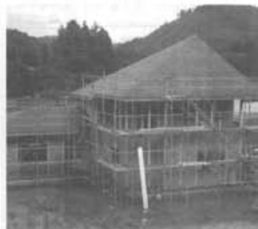
山辺町 樋口勝蔵様 住宅新築工事
