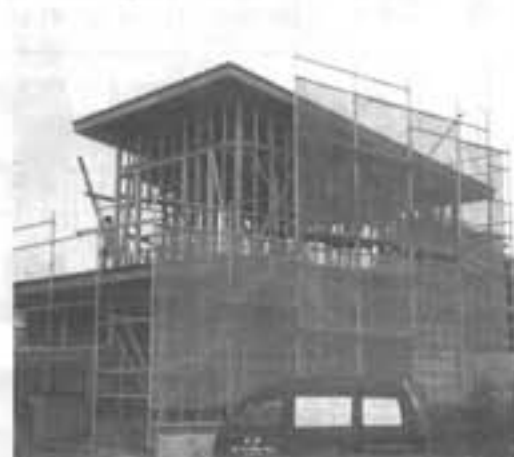
中野 遠藤つや子様 住宅増築工事
