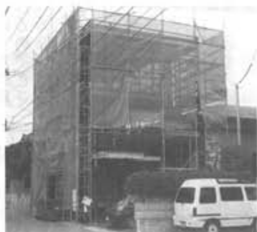
下条町 伊藤 愛様 住宅増築工事
