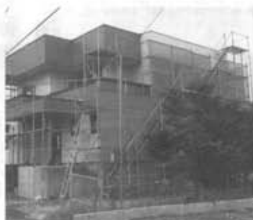
陣場新田 武田久雄様 住宅新築工事
