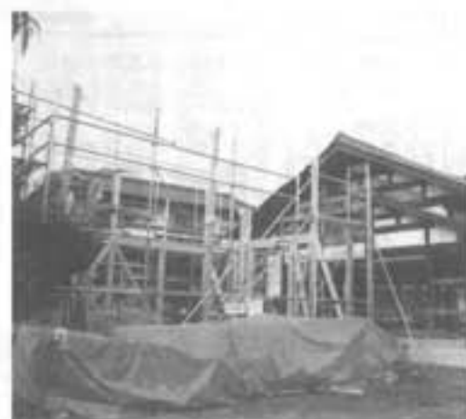
小姓町 佐藤治雄様 住宅引舞及増築工事
