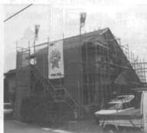
江南 鈴木正美様 住宅新築工事
