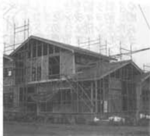
陣場新田 加藤 繁様 住宅新築工事
