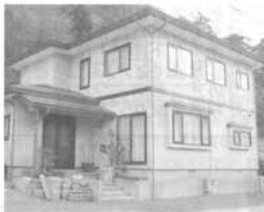
松 山 木村昌一様 住宅新築工事
