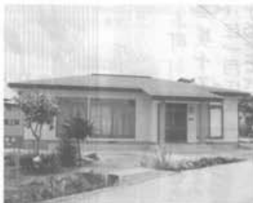
陣場新田 堀 正夫様 住宅新築工事
