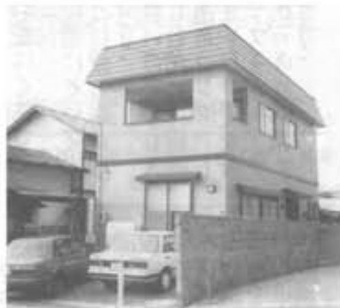
小姓町 富沢 誠様 住宅新築工事
