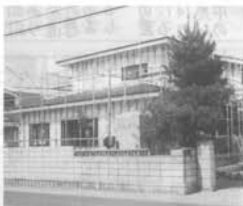
陣場新田 斎藤秀信様 住宅新築工事
