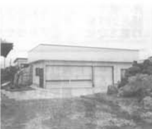
陣場新田 斎藤林助様 車庫新築工事
