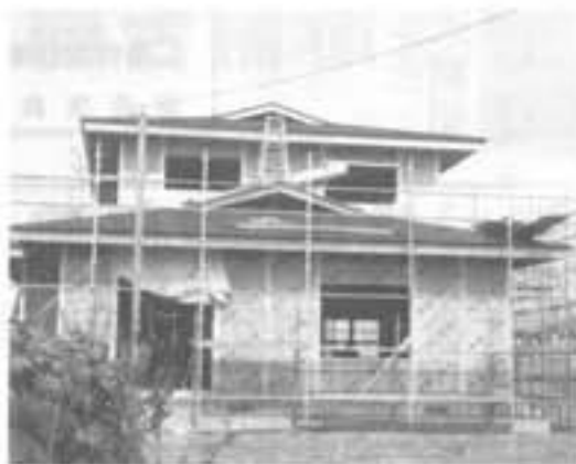
陣場新田 武田哲太郎様 住宅新築工事
