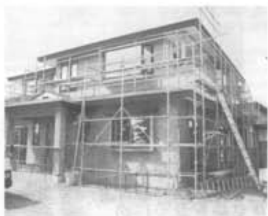
東志戸田 栗原 勉様 住宅新築工事
