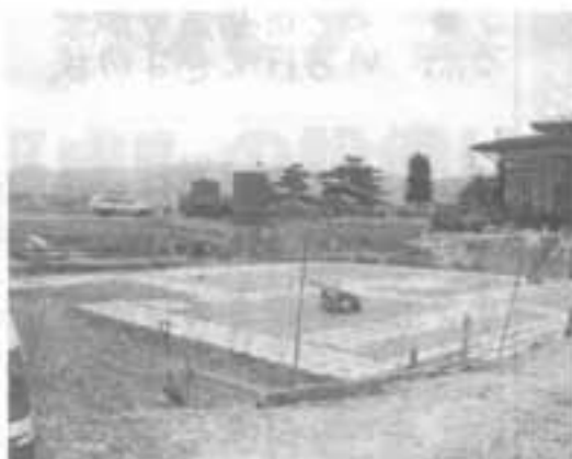
陣場新田 武田久雄様 住宅新築工事 (軟弱地盤改良工事 コマ杭打ち込み)
