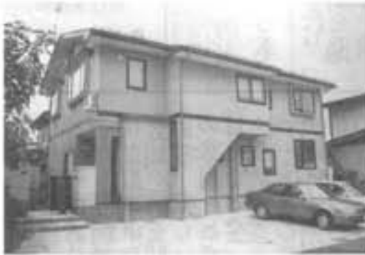
漆山 杏澤 勝様 住宅新築工事
