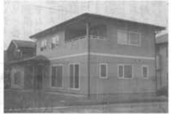
天童市 佐藤健治様 住宅新築工事
