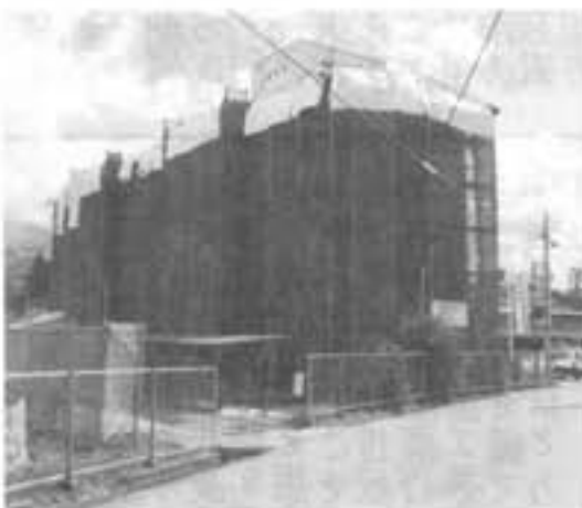
山形市営 南山形住宅B棟 外壁等改修工事
