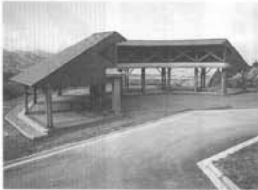
山形市 「西藏王市民の森林」 休憩施設新築工事
