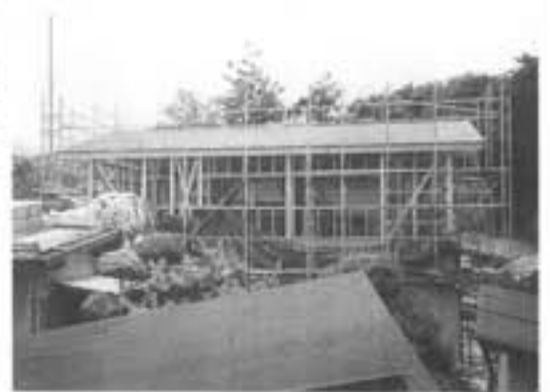
上山市 荒井清兵衛様 住宅増築工事
