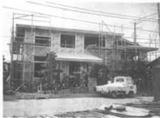
西田 荒木大三郎様 住宅新築工事
