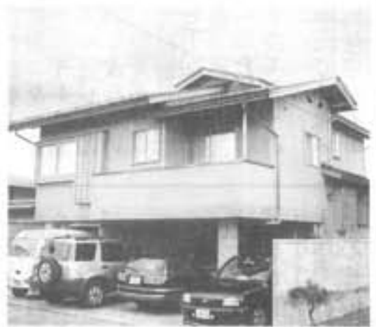
西田 石井美智子様 住宅新築工事
