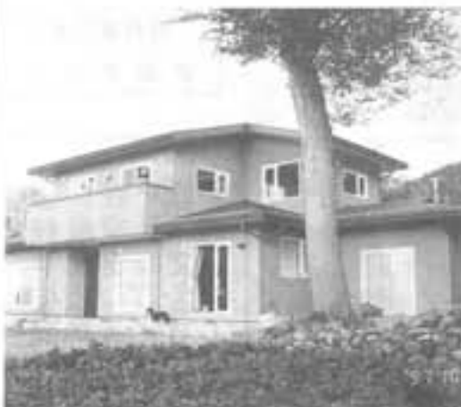
岩波 河合誠一様 住宅新築工事
