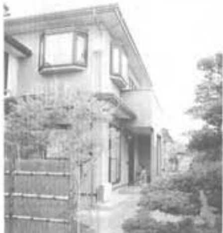
陣場新田 武田善光様 住宅新築工事
