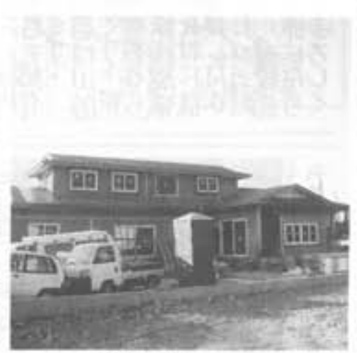
鷺ノ森 金山兼一様 住宅新築工事
