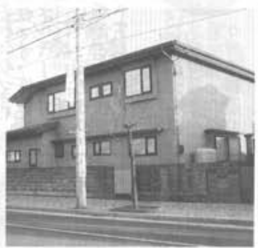
天堂市 半田慧子様 住宅新築工事
