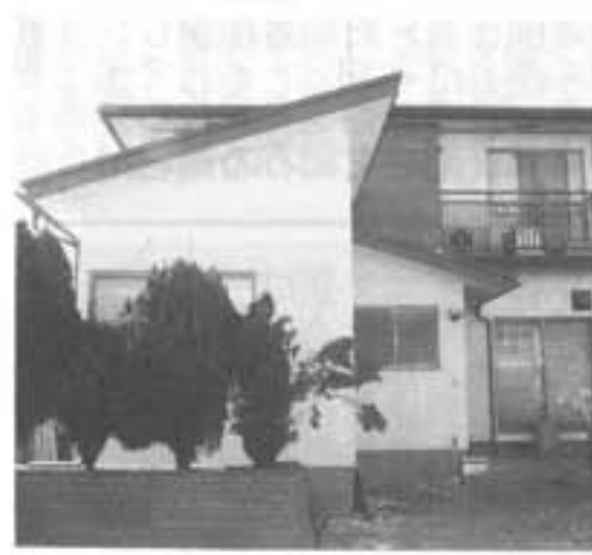
高堂 中村慎一様 住宅増築工事
