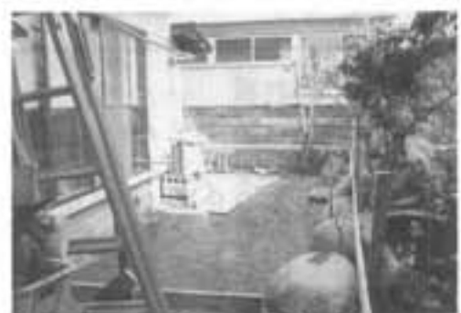
東原町 本間信吉様 増築工事
