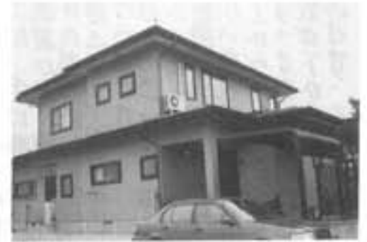
山辺町 後藤 仁様邸 新築工事(FP工法)
