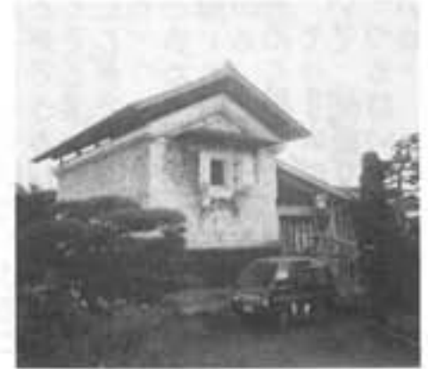
沼 木 里見皓一様 蔵座敷増築工事
