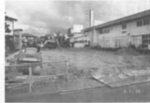
山形市立金井小学校プール建設工事
