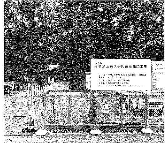
山形市霞城公園 東大門便所改修工事
