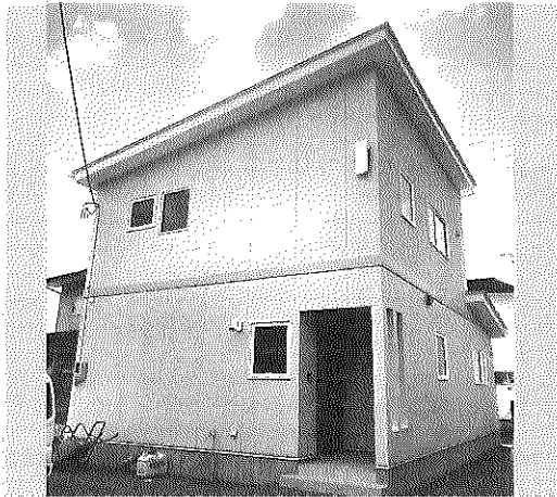
上山市内 H様邸 住宅新築工事
