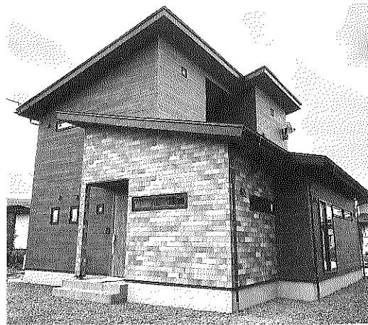
陸場新田地内 S様邸 住宅新築工事
